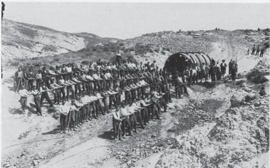
1927, Località Junture. Trasporto di un tronco di condotta per lo sbarramento artificiale della Società Elettrica Meridionale, alla confluenza dei fiumi Arvo e Neto.
