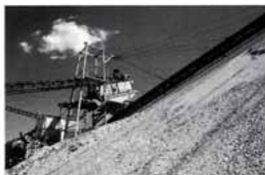
Un po' di cantiere Foto di Germano Guzzoni
