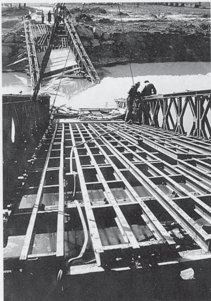
Bastia: il ponte di emergenza crollato Foto di Beppe Cavallotto (G.F. Albese)
