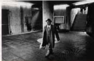
Sottopassaggio n.3 Foto di G. Merlo
