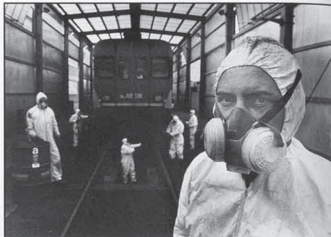
BANI ANGELO (Italia) "Disinfestazione amianto"
