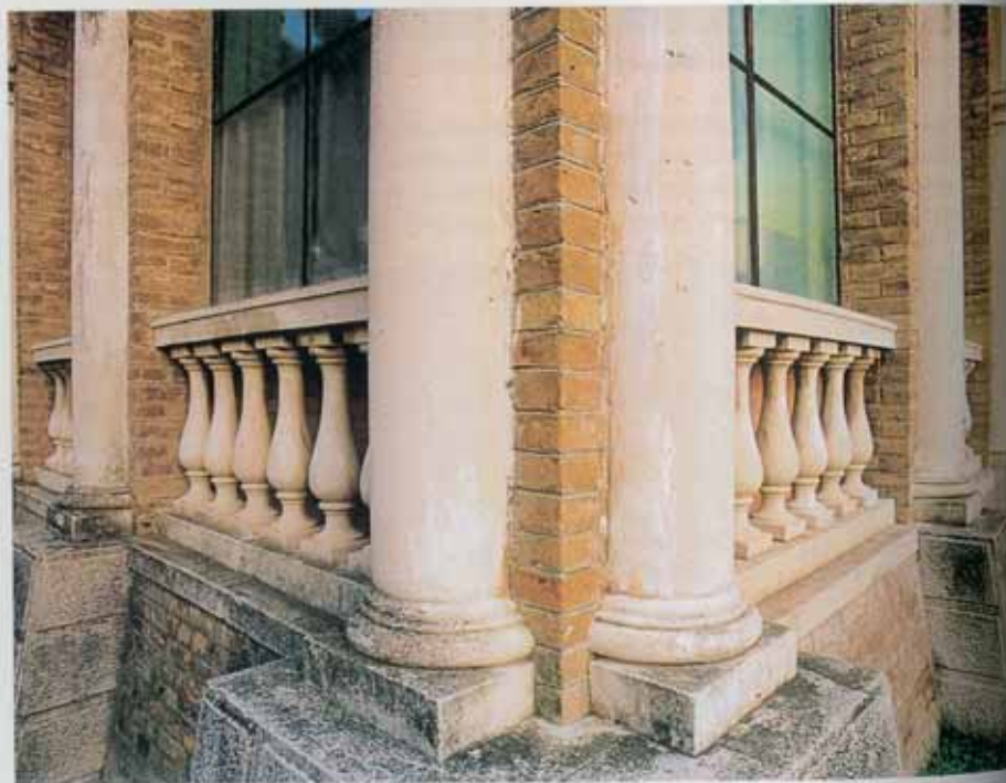
Rosignano Solvay, Teatro, particolare delle finestre del piano terreno Foto di Enrico Genovesi
