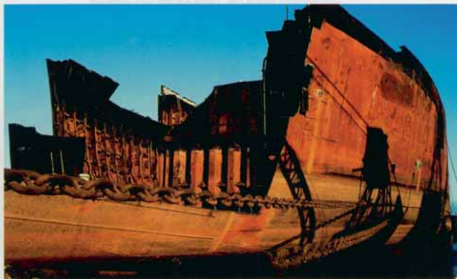
Dalla Monografia Giovanni Roni - Lo scafo sullo scalo di alaggio per la demolizione Foto di Giovanni Roni
